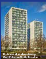
Umbau und Modernisierung Gref-Palucca-Straße Dresden
