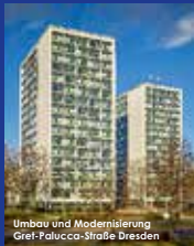
Umbau und Modernisierung Graf-Palucca-Strasse Dresden
